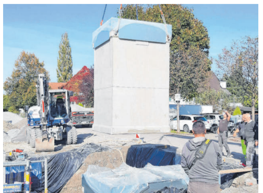
Die neuen Unterflursammelbehälter beim Spar-Markt sind mittlerweile bereits fertig und betriebsbereit.
